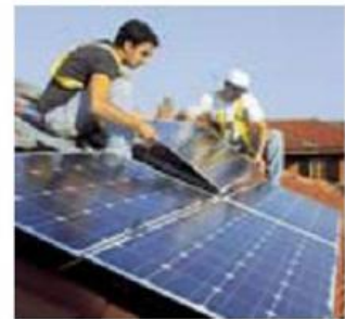
Installazione di pannelli solari
