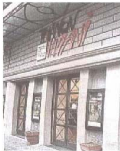
Ripresa La facciata del Trianon: fallimento evitato in extremis
