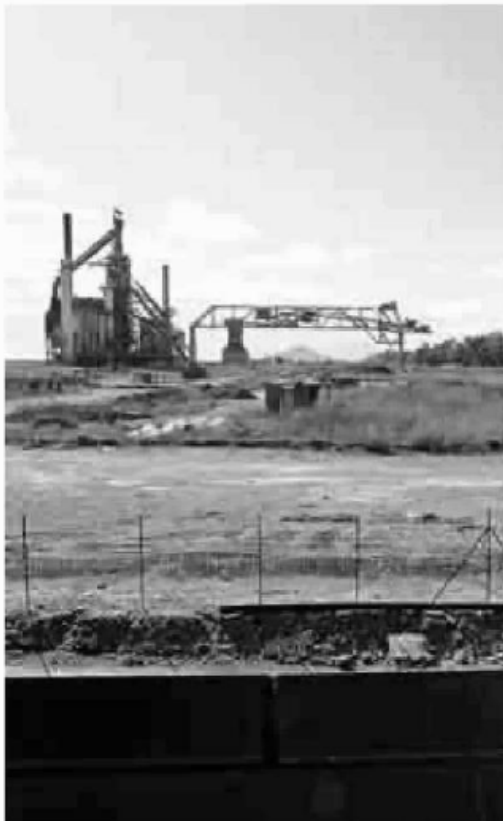
Attesa Una veduta dell'area di Bagnoli: progetti al palo
